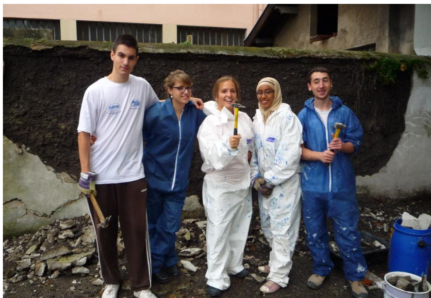
Chantier: nettoyage, peinture...
